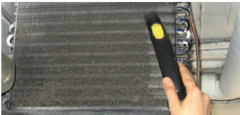
Regelmäßig Kühlrippen entstauben (z. B. mit einem Staubsauger).
